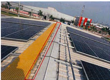
ภาพที่ 2-66 สาย Life Line บริเวณหลังคาอาคาร
