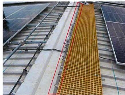
ภาพที่ 2-66 สาย Life Line บริเวณหลังคาอาคาร
