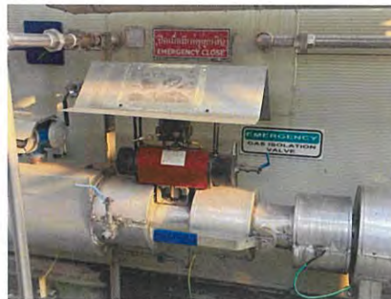
ระบบควบคุมการ Shutdown 2
