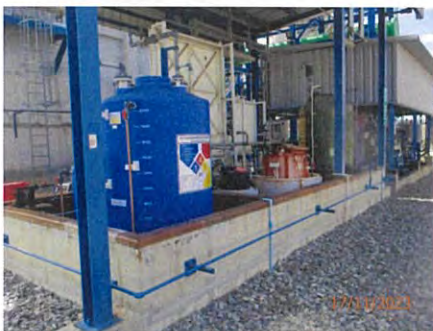
ภาพที่ 2-58 คันกั้นสารเคมีหกรั่วไหล
