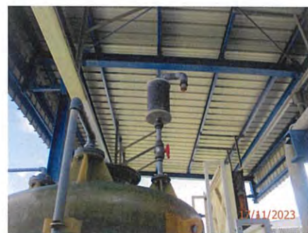
ภาพที่ 2-59 Activated carbon บริเวณถังเก็บสารเคมี
